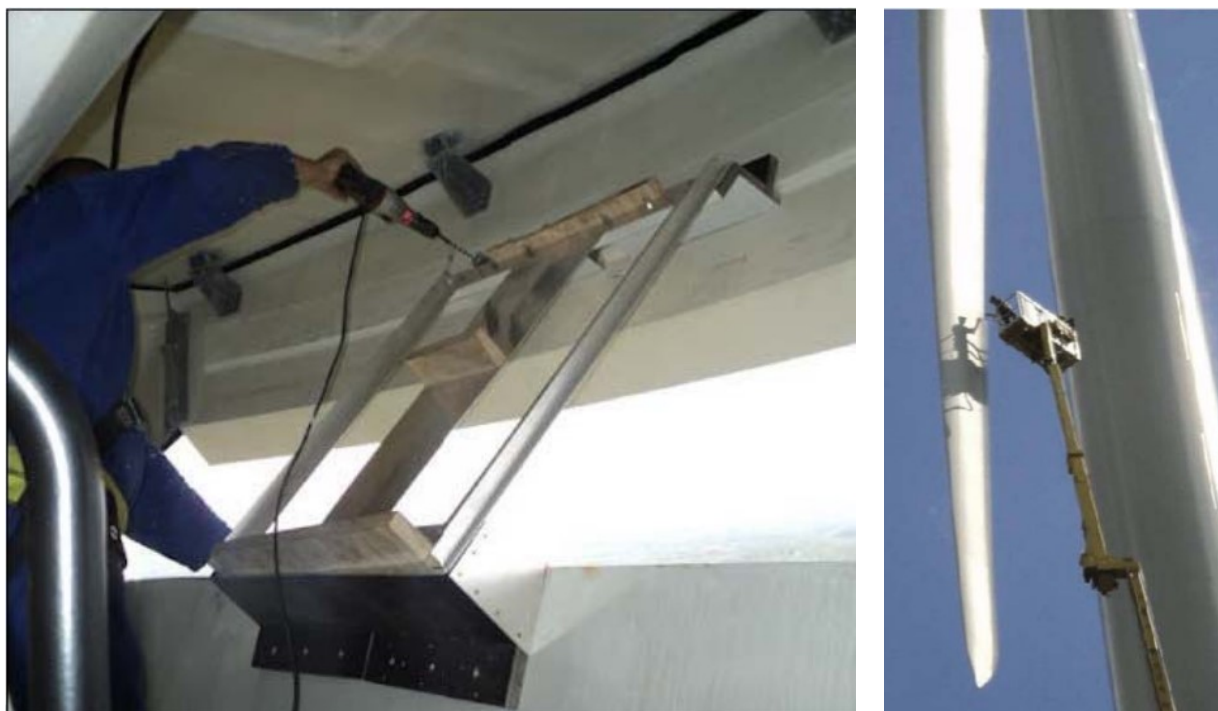
Figur 2 - "Hajtänder" skruvas på verk i Laholms kn för att akut lösa bullerproblem 66 .
